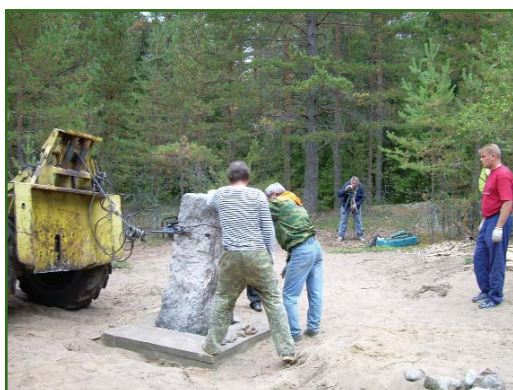
Рис. 2 Установка астрономического гранитного столба
